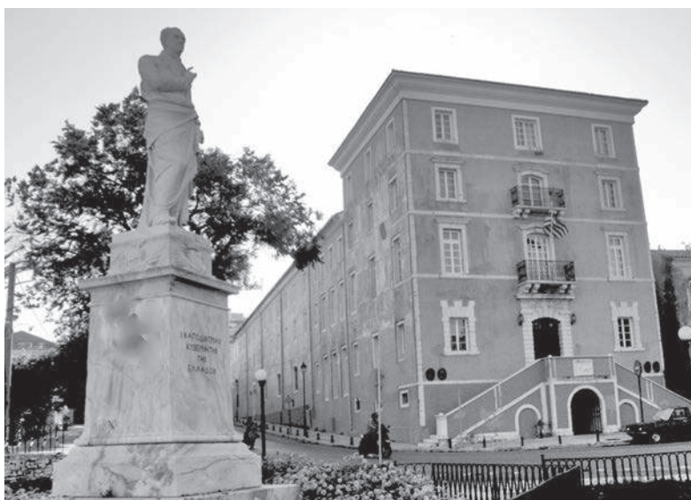
Εικ. 1. Το αναπλασμένο κτίριο του Ιονικού Κολεγίου, αριστερά μετά την Ιόνιο Ακαδημία (2014).
