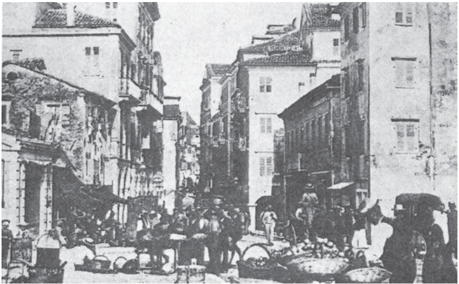
Άποψη της εσωτερικής πλευράς της Πόρτα Ριάλας. Η σημερινή οδός Ευγενίου Βουλγάρεως, στην Κέρκυρα, πριν από την κατεδάφιση της Πόρτας Ριάλας (1891). Κτήρια σώζονται μέχρι σήμερα.
