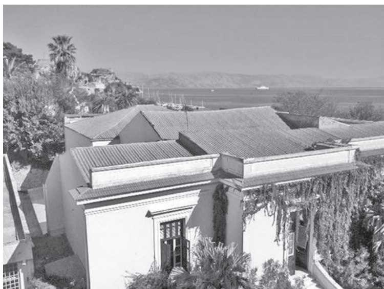
Εικ. 3: Η σύνθετη στέγη του κτηρίου, όπως φαίνεται από γειτονικό κτίσμα.
