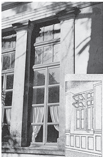
Εικ. 4. Δημοτικό Σχολείο Δουκάδων, Κέρκυρα. Το άνοιγμα ακολουθεί το πρότυπο του Διατάγματος του 1894.
