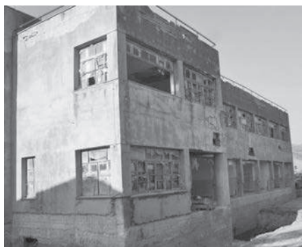
Εικ. 6. Δημοτικό Σχολείο Αηξουρίου Κεφαλονιάς. Αρχιτέκτων Θουκυδίδης Βαλεντής.
