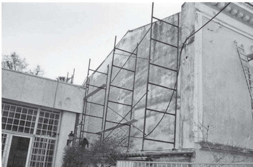
Εικ. 4: Το τμήμα του δυτικού εξωτερικού τοίχου που καθαιρέθηκε, μετατοπίστηκε και αντικαταστάθηκε το 1963 (Αρχείο Η' Ε.Π.Κ.Α.).
